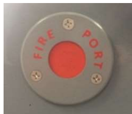
Brandöppning på konsolens öppningssida.
